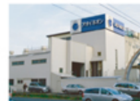
東京本社・工場
