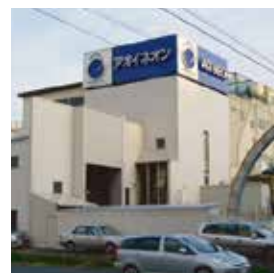
東京本社・工場
