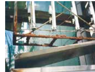
袖看板内部鉄骨
