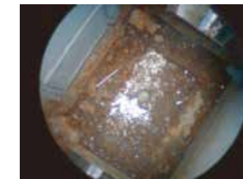
ブラケット内部鉄骨
