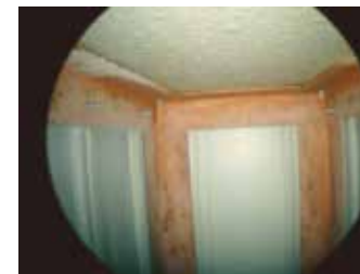
袖看板内部鉄骨
