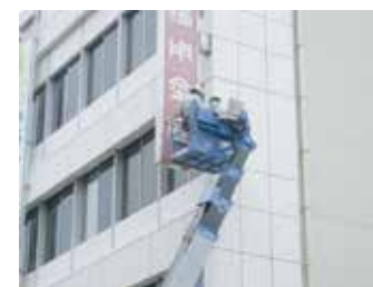
看板を取り外さずにアンカーボルトの引抜き耐力試験を行う事ができます。
