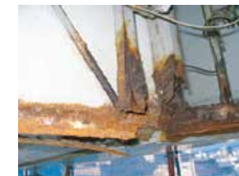
屋上広告塔下端鉄骨
